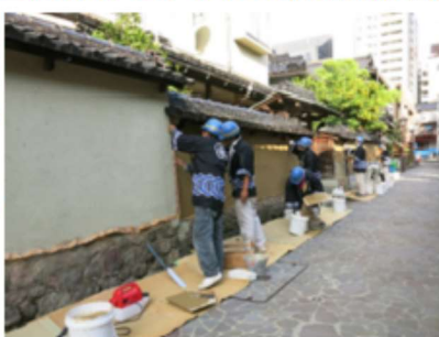
土塀修復の様子
