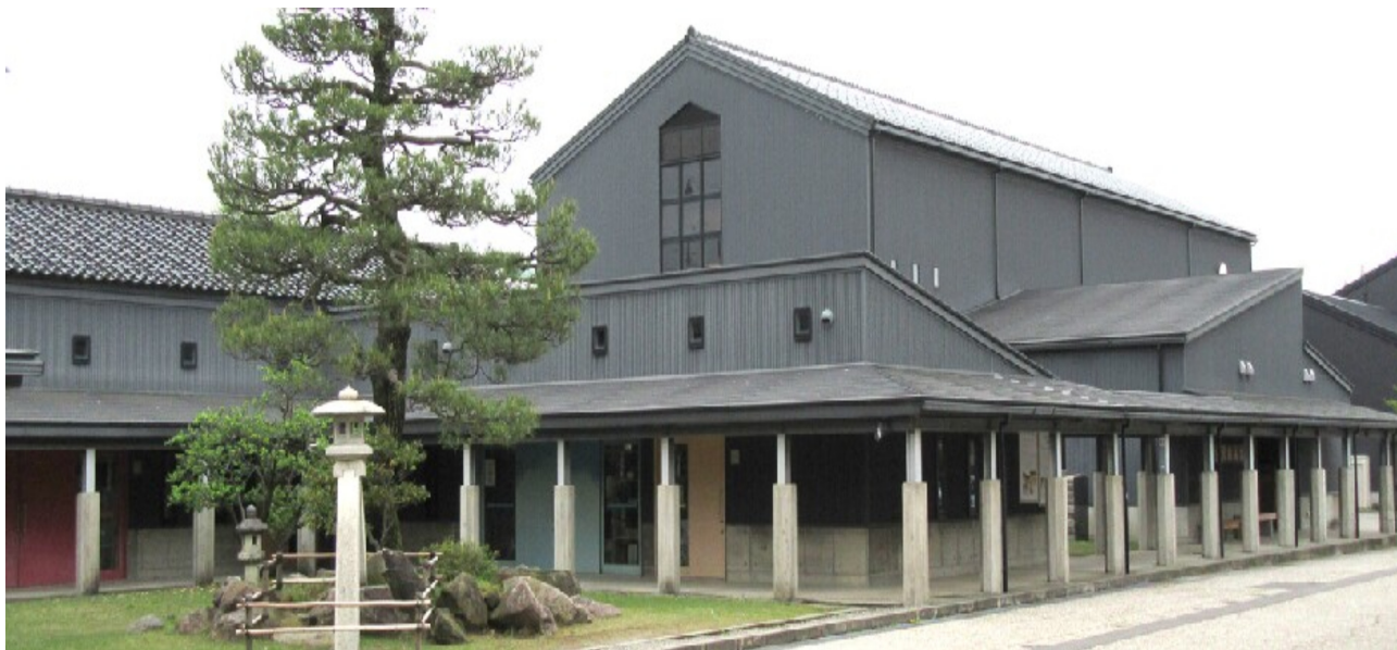
金沢職人大学校の建物
