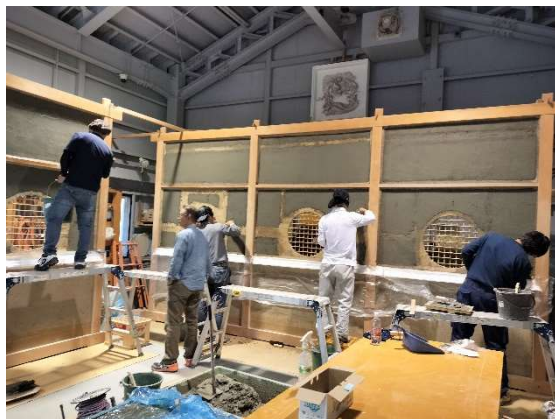
左官科：土壁、底埋め、海鼠、瓦貼り
