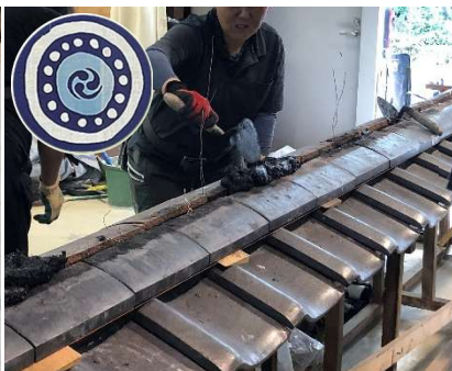
[瓦] 和瓦の棟積み
