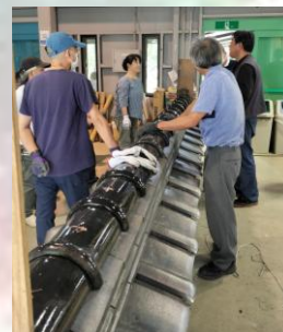
〔瓦科〕 和瓦の棟積み
