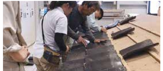
▲瓦葺演習→研修生自身が仕分けた棧瓦を実際に葺いてみる。大きさや反り具合が一枚ずつ異なる為スムーズな配置が難しい。
